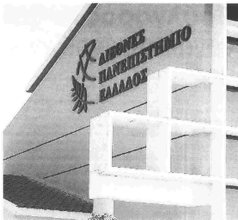
Το κτίριο του Διεθνούς Πανεπιστημίου στη Θεσσαλονίκη σχεδιάζεται να συνδεθεί με το λεγόμενο «ευφυές» δίκτυο ηλεκτροδότησης.
